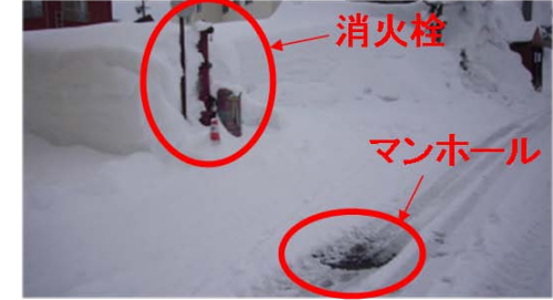
雪に隠れた道路設備
